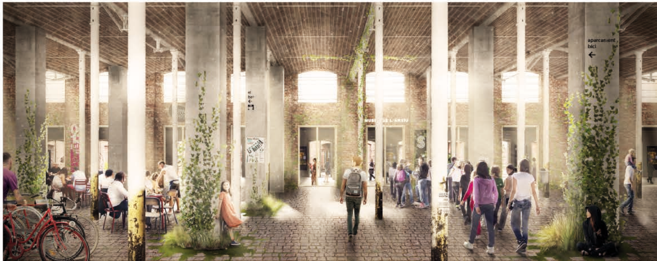
Vista transversal de la Plaça - pilars de fosa i voltes originals, pilars de formigó amb a nova estructura de l'Anxi situat a les plantes superiors
