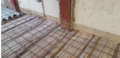
RESTITUCIÓ DE REVESTIMENTS
