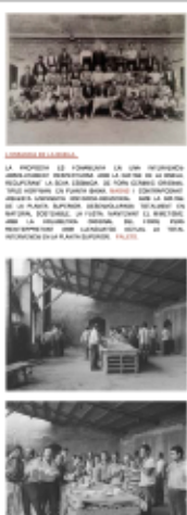
EL PROCÉS CONSTRUCTIU
