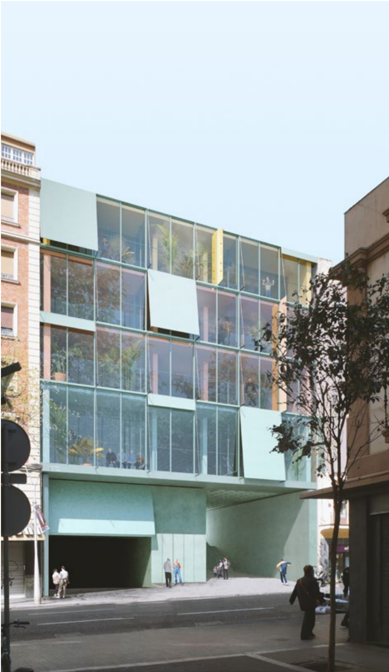
Façana Carrer de Mallorca
