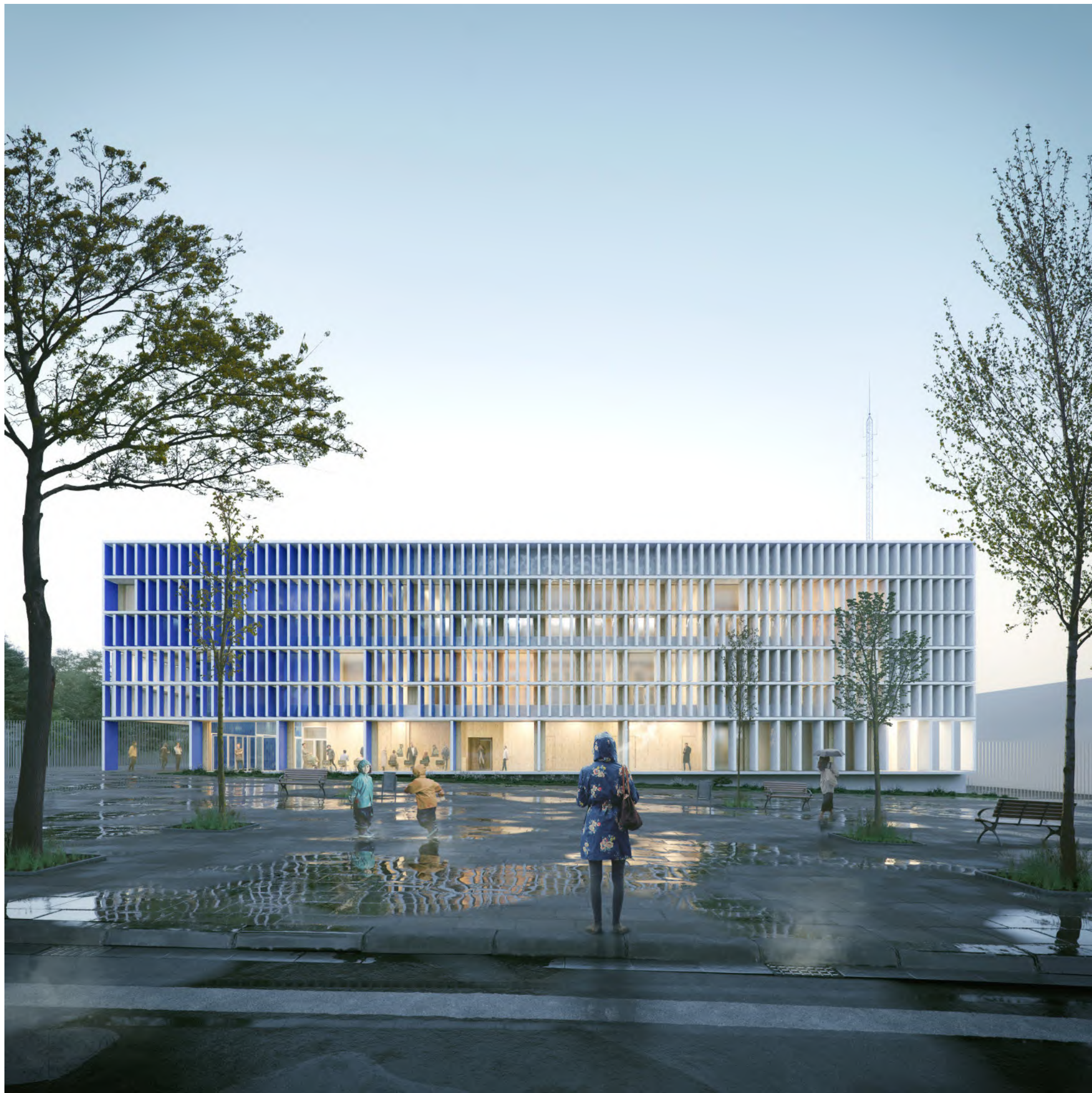
Vista exterior de la façana principal
