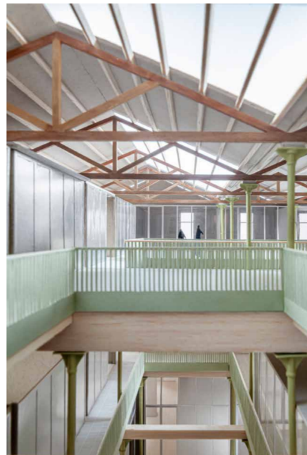
El buit i la llum - La posició dels patis es correspon a la coberta amb les lluernes. La llum baixa a través del solapament dels forjats fins a la plaça interior.
