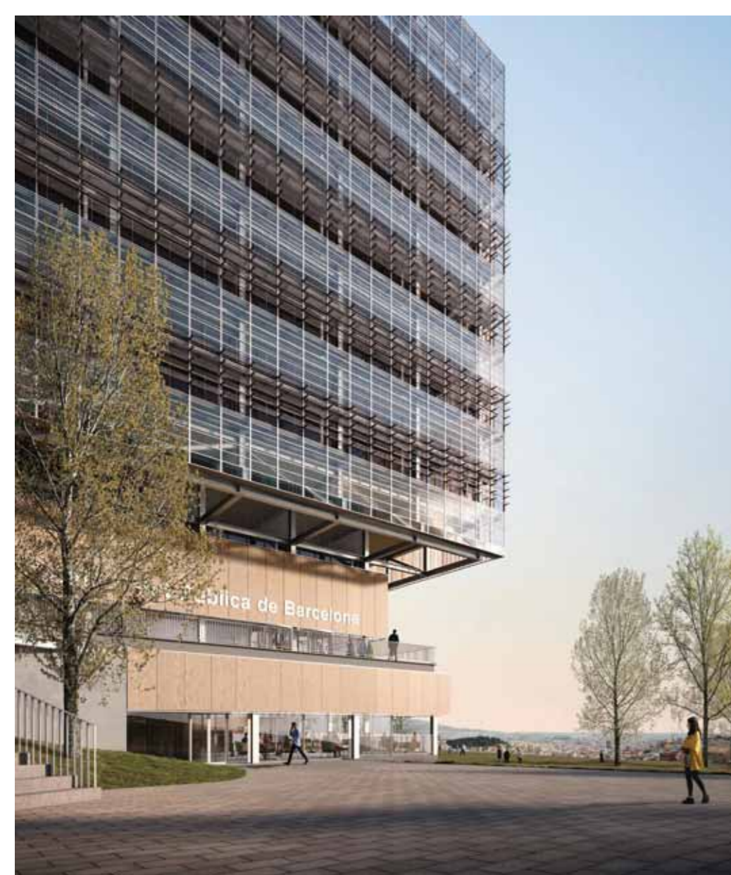
La doble pell de la façana sud configura una galeria amb doble funcionament de regulació climàtica: coïx tèrmic i captador solar a l'hivern aprofitant l'aire calent per al besanvi dels recuperadors i xemeïa de ventilació a l'estiu.
