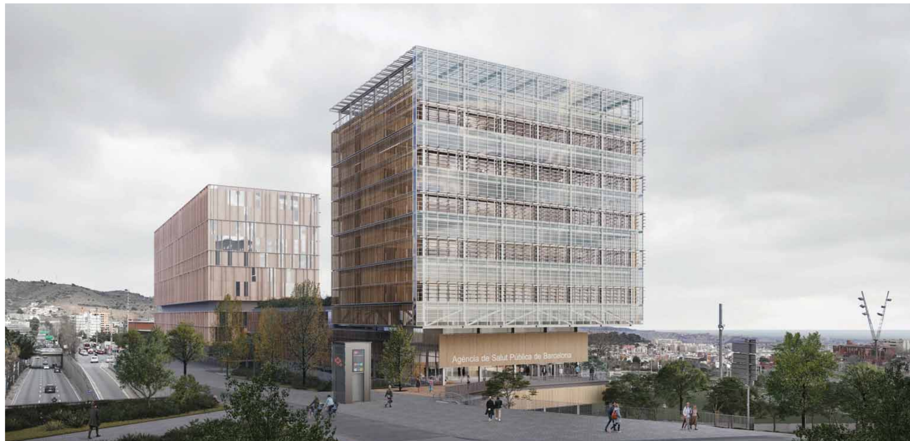
L'encaix de l'edifici allibera una franja verda que reforça el caràcter pacífic dels laterals de la Ronda. El cos alt esdevé l'element emblemàtic del compromís mediambiental de la nova seu de la institució, amb la pergola fotovoltaica a la coberta i la façana bioclimàtica en voladís sobre l'accés principal.
