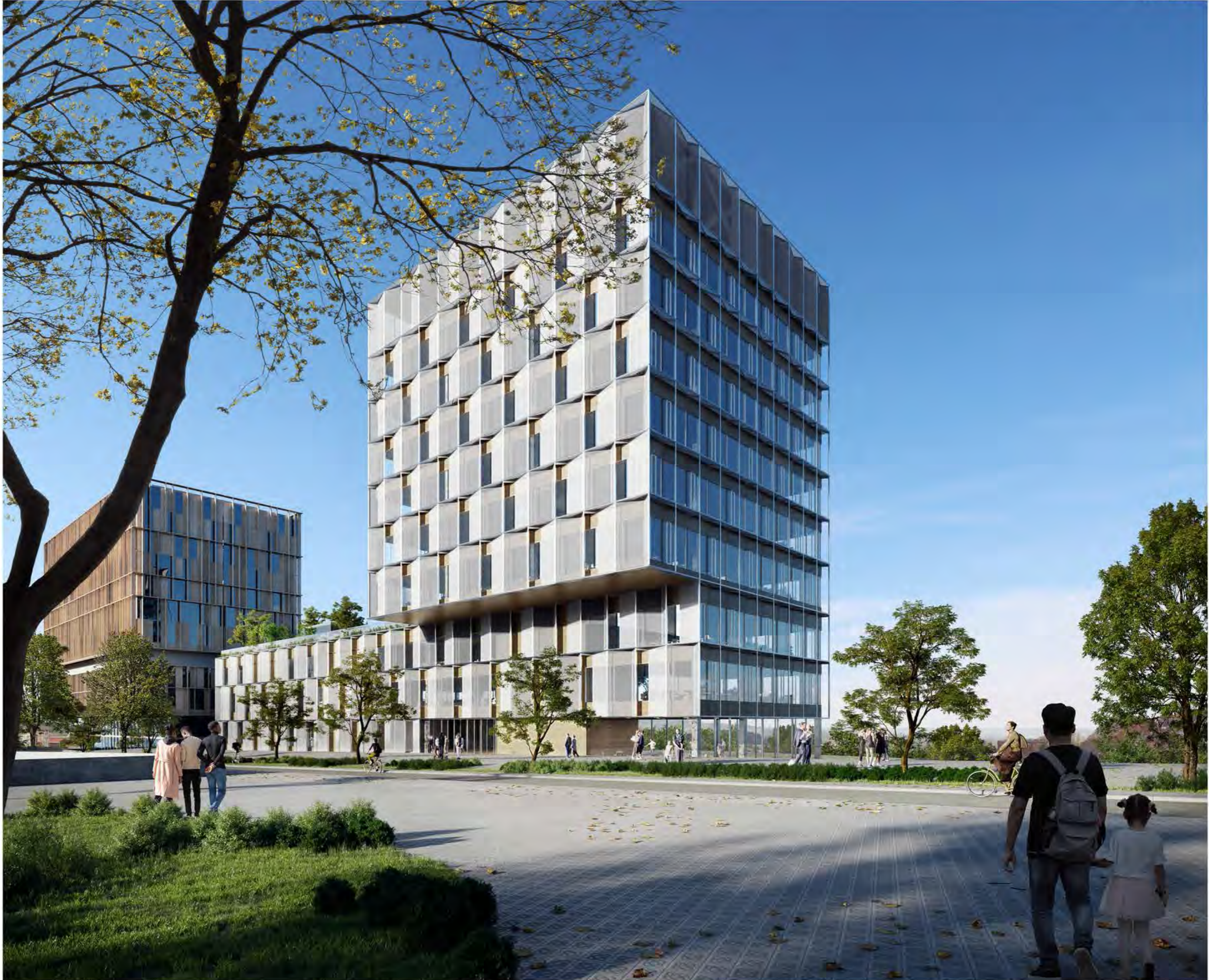
vista des del Passeig de la Vall d'Hebrón - planta d'accés transparent i integrada amb el parc-mirador - a partir de mitgia la façana sud, en ombra, replega els seus estors i s'obre totalment
