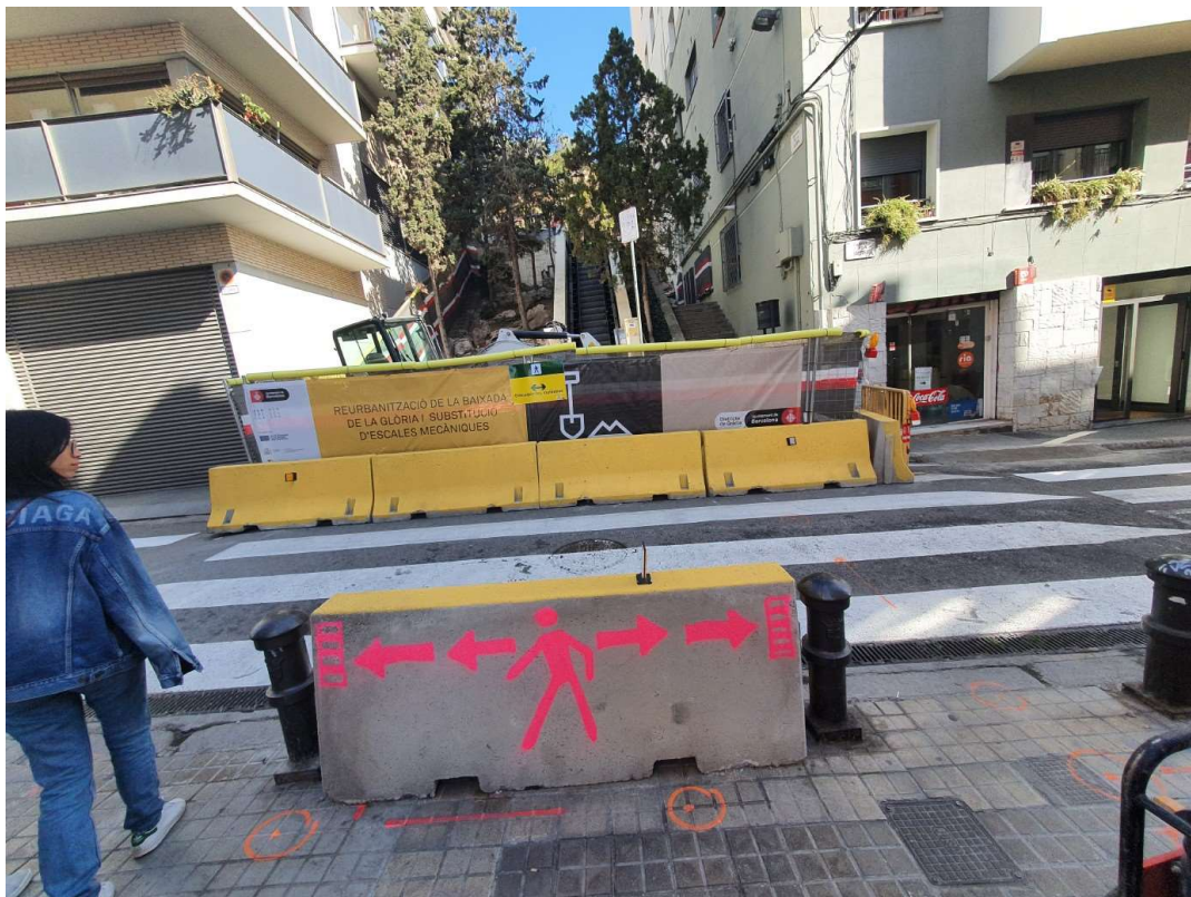
Carrer Sostres cruïlla Baixada de la Glòria
