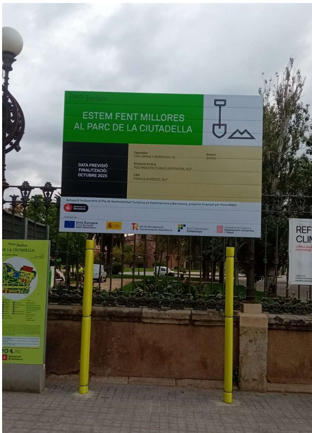
Cartell d'obres ubicat a l'accés de passeig Pujades
