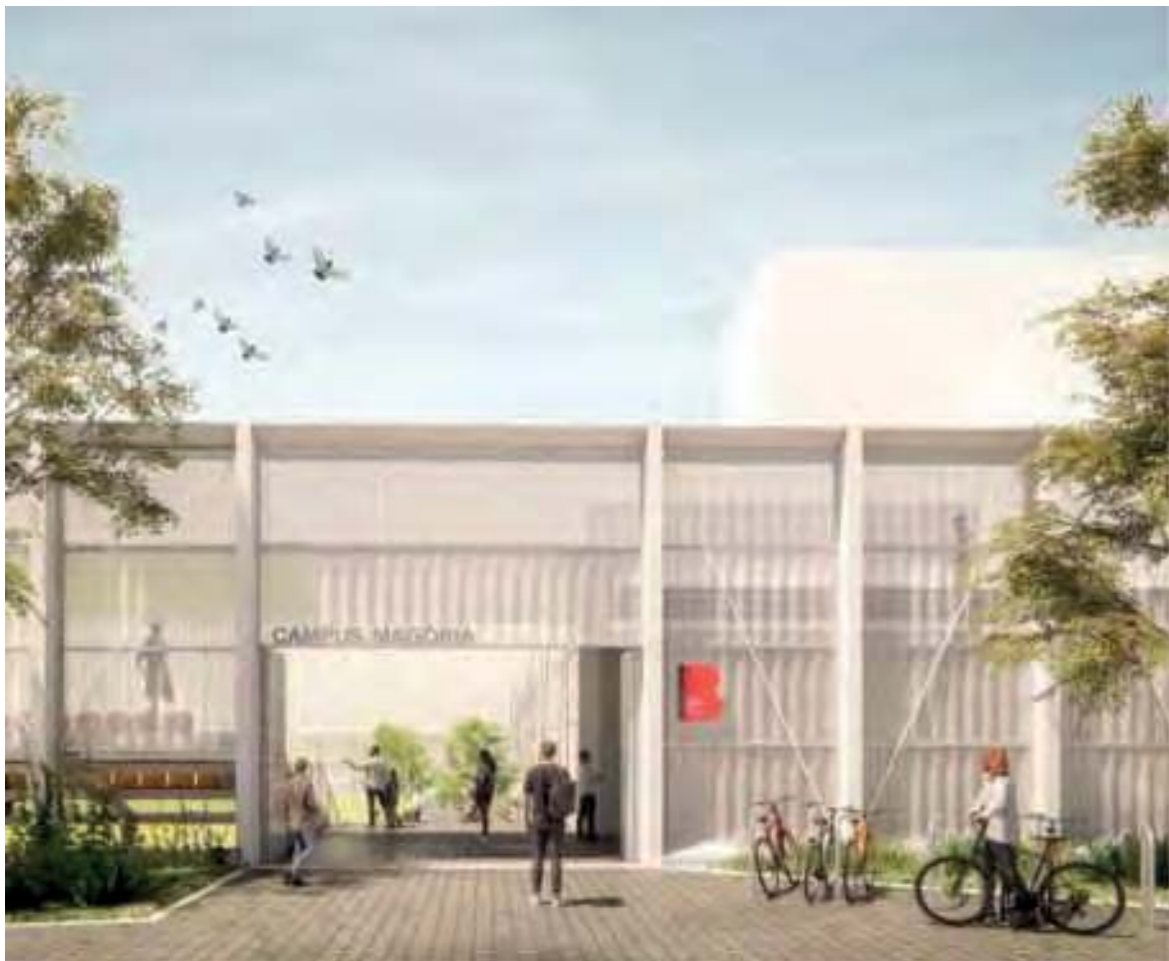
Vista de l'accés des del carrer Corral. Modulació de l'estructura permet penjar una façana lleugera metàl·lica semitransparent
