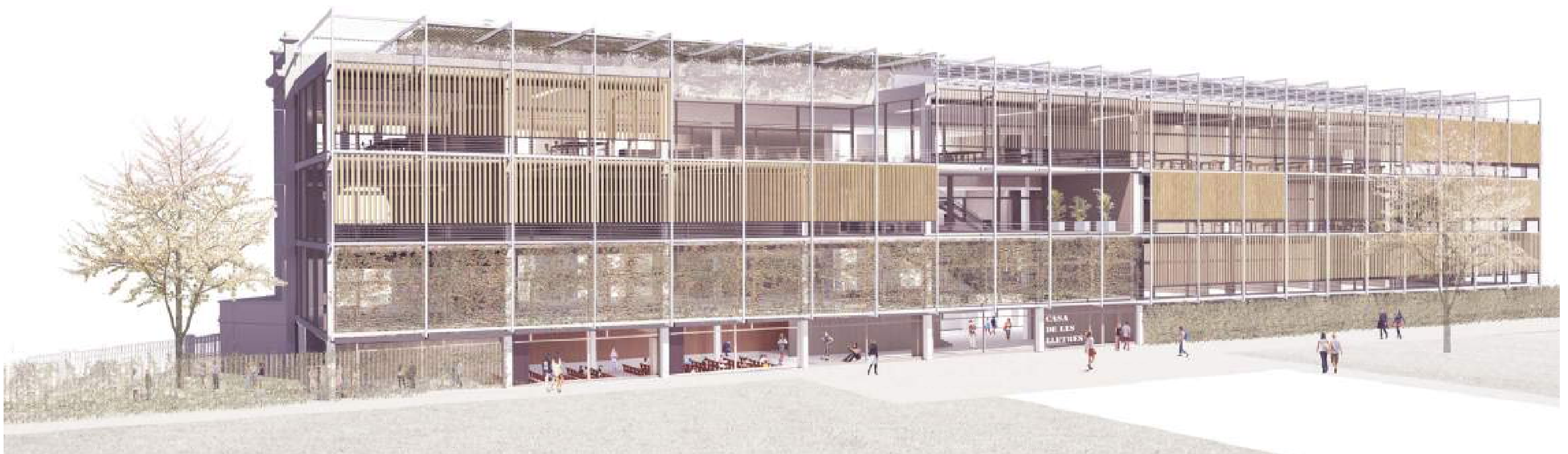
La façana sud-oest s'incorpora a l'espai verd de l'interior d'illa com una pèrgola vertical amb una estructura lleugera, lames de fusta orientables i vegetació enfiladissa
