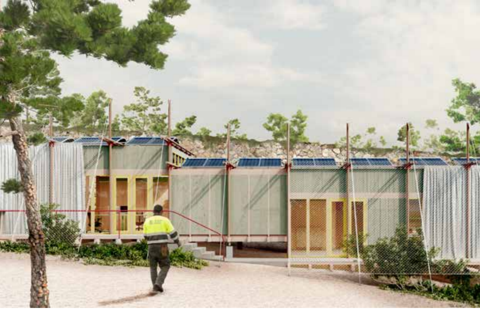
Una edificació lleugera, prima i allargassada —estagues de fusta amb una pèrgola fotovoltaica— que podria desmuntar-se i reciclar-se fàcilment en un futur, per restituir el paisatge original
